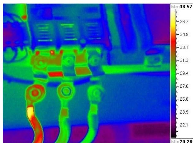
Рисунок 21. Пример термограммы контактных соединений с температурной шкалой
